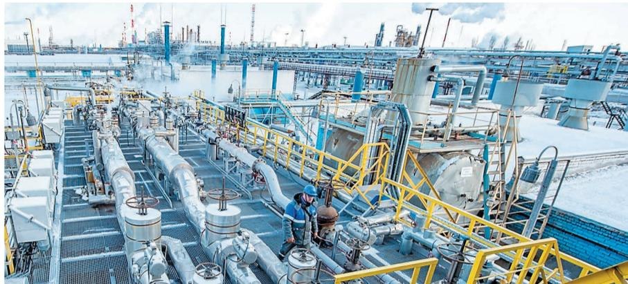
Установка производства серы – конечная стадия переработки нефти и газа при наличии в них сероводорода. Основная задача – достижение 99,5 % извлечения серы
