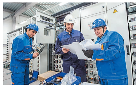
Настройка схем управления цитового электрооборудования на комплексе каталитического крекинга
