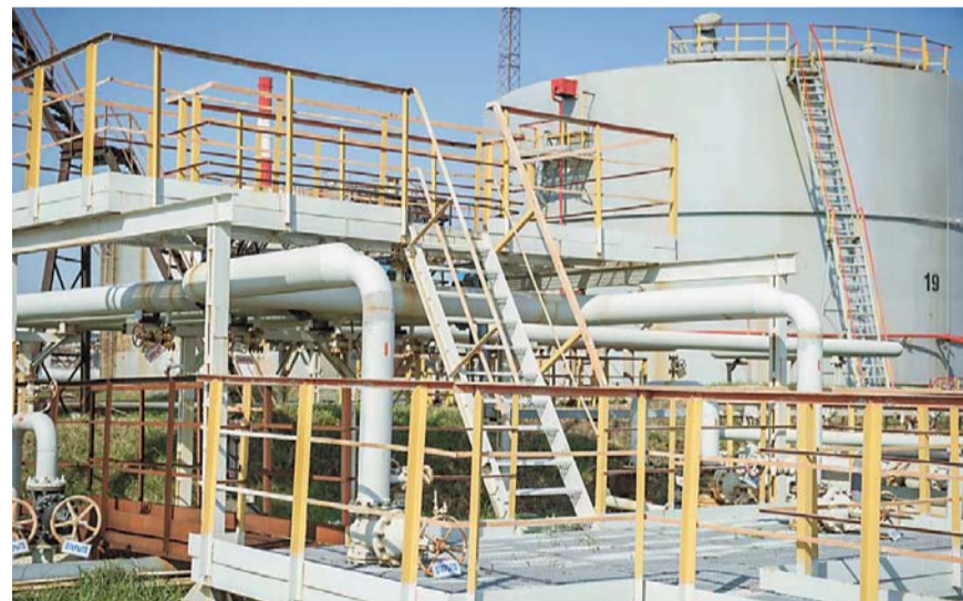
На объекте смонтирован дополнительный всасывающий трубопровод для сокращения времени налива дистиллята газового конденсата
