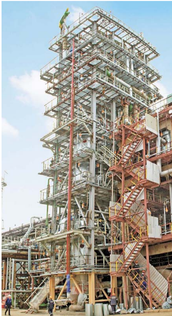
Работы по замене реактора начались задолго до ремонта. На отдельной площадке около цеха № 58 еще в мае велась сборка 41-метровой этажерки, на которой сейчас расположено два трехслойных реактора гидрирования ацетиленов
