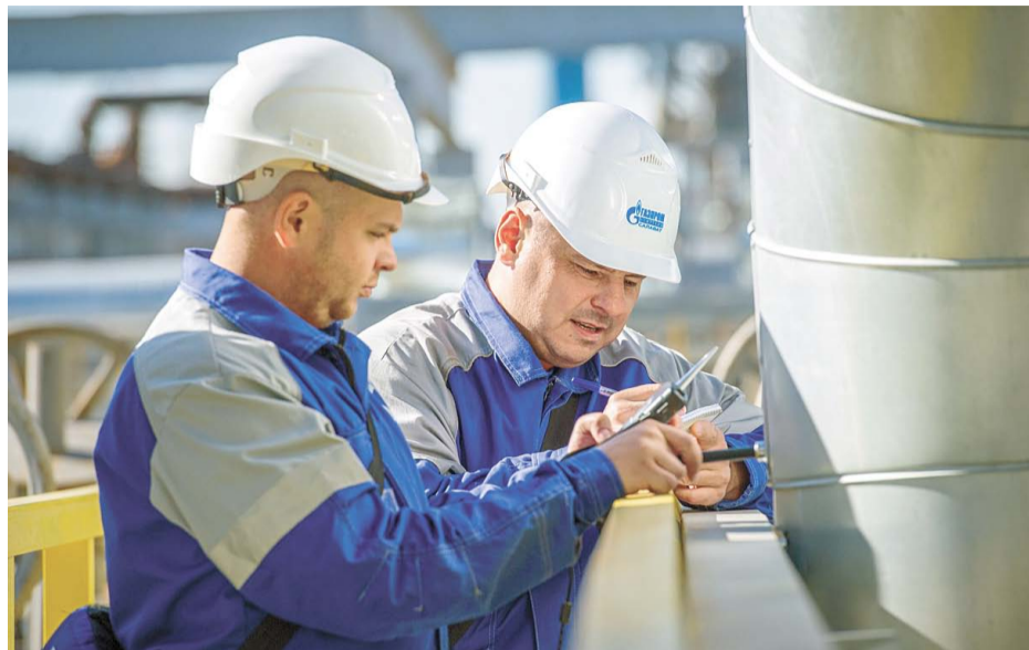
Специалисты лаборатории обследуют изоляцию трубопровода «Пар-140», по которому будет подаваться пар на производство ЭП-300
