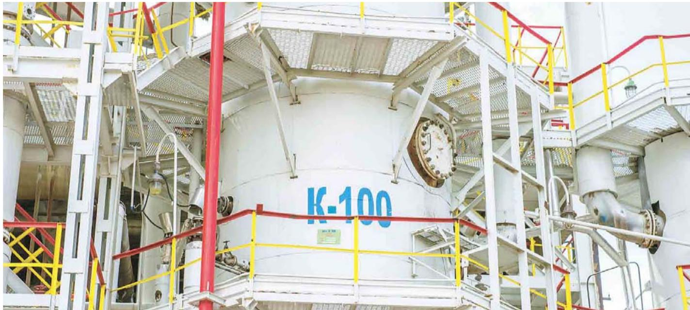
Колонна очистки конвертируемого газа работает на новой насадке фирмы «Петон»
