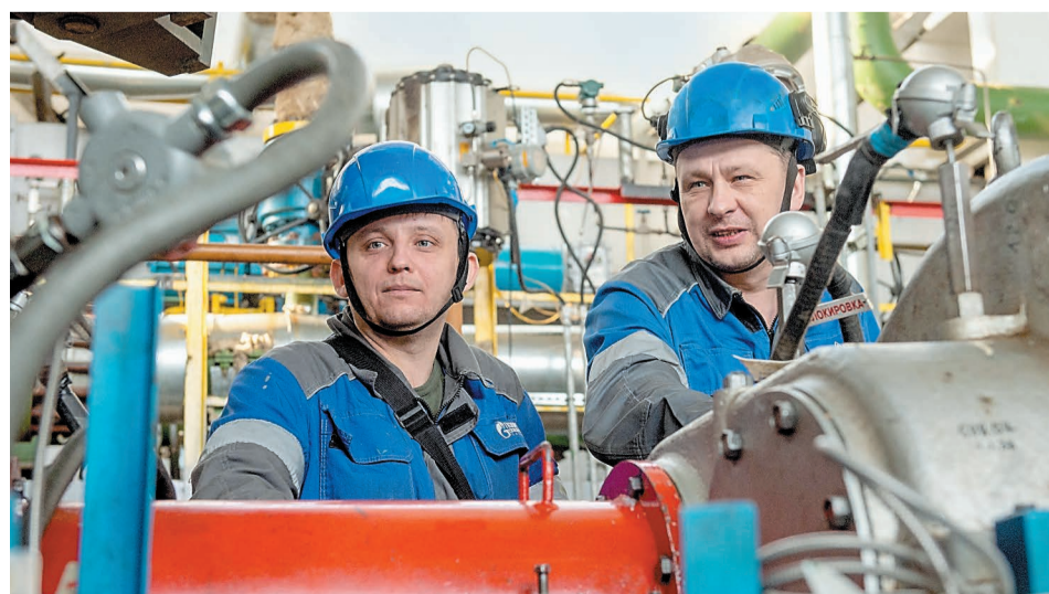
Машинист Дмитрий Пулькин и старший машинист Сергей Кабатов производят визуальный контроль подачи масла к точкам смазки компрессора АК-101
