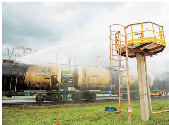
Чтобы снизить разрушения эстакады, на стационарный источник пожаротушения из повысительных насосов подается вода
