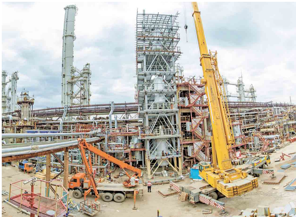
Новые реакторы цеха № 56 позволят увеличить нагрузку по этан-этиленовой фракции на реакторный блок. Кроме того, за счет использования трех слоев гидрирования удастся увеличить селективность процесса гидрирования
