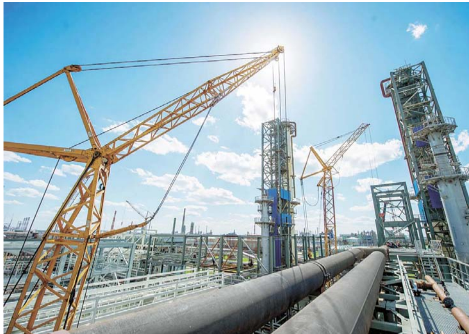
Строительство установки изомеризации в Салавате
