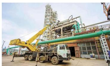
рода К-100 установки получения смеси углерода и водорода цеха № 51 произведена замена старой насадки «Петон» на новую аналогичной фирмы.
