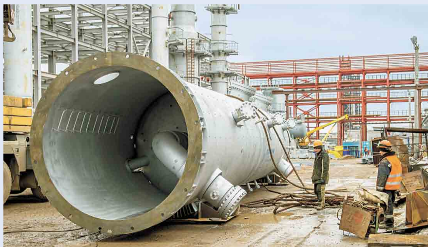
Габаритный реактор для первой стадии гидроочистки бензина каталитического крекинга позиции Р-2002 привезен и установлен на строящемся комплексе. Высота реактора 19,6 м, диаметр – 2,8 м. Максимальная температура процесса в нем составит 340 градусов, давление – 19,6 кгс/см 2 .
