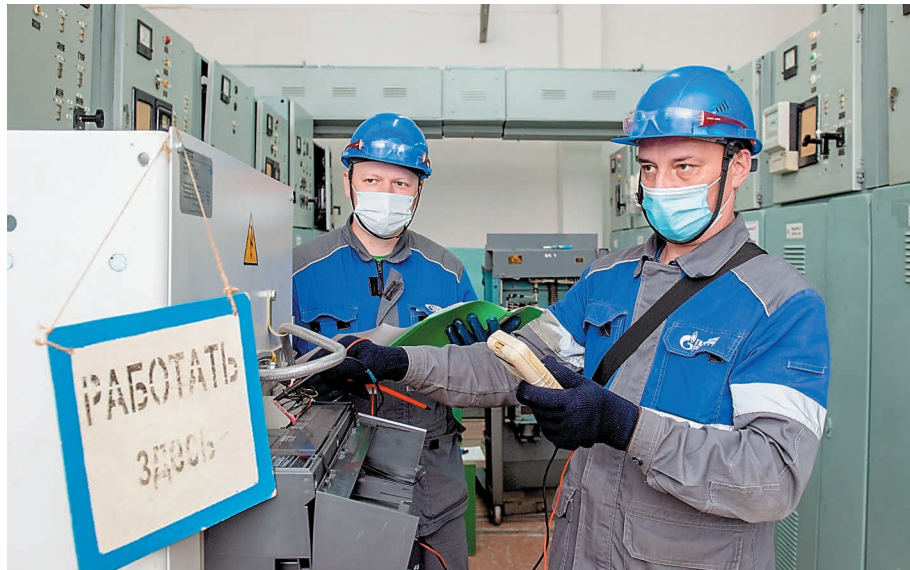
Замена устаревшего оборудования релейной защиты
