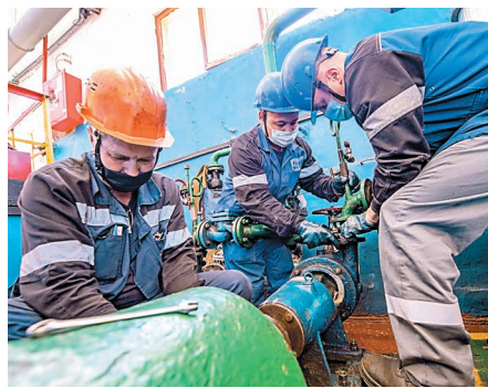
Сборка центробежного насоса поз. Н-7
