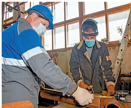
Изготовление отопительной гребенки
