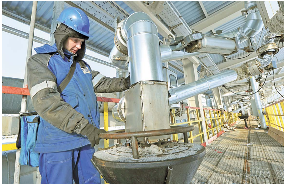
Ремонт установки по производству битумов и АГФУ-2 идет строго по графику. В конце каждого дня подводят итоги, выдают задания на следующий день
