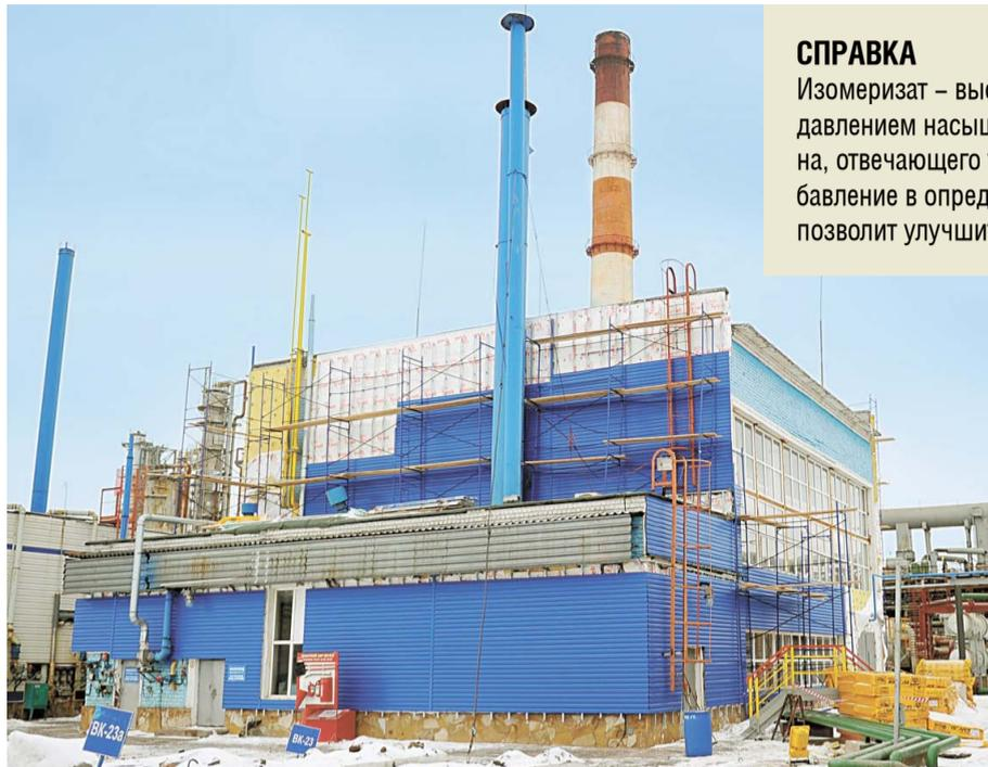
За последние два месяца на установке изомеризации выполнен монтаж более 70 аппаратов, в том числе четырех крупногабаритных колонн, смонтировано 12 единиц теплообменного и 14 единиц емкостного оборудования.
