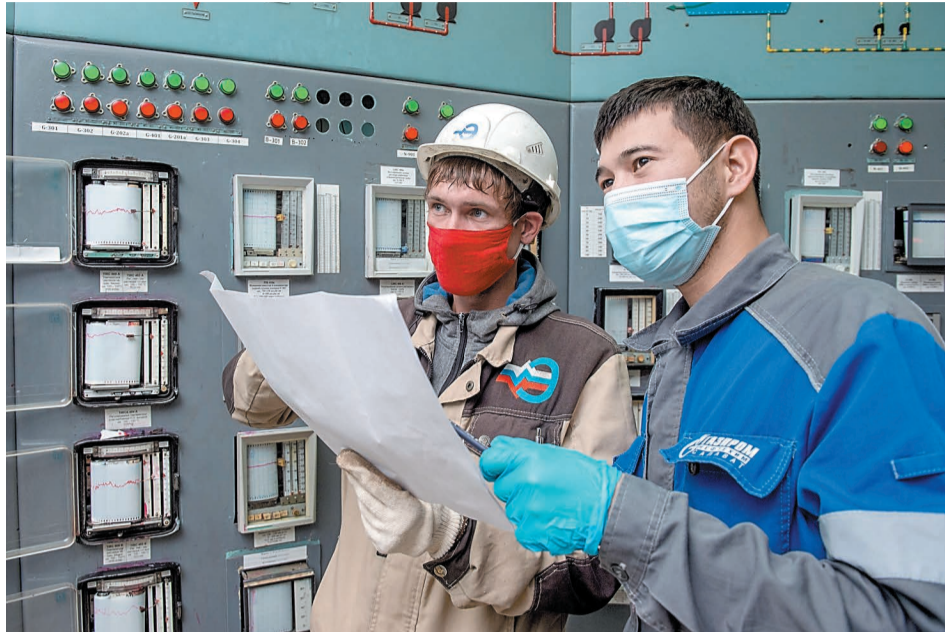
Капитальный ремонт проводился в период пандемии, что наложило дополнительные обязанности по соблюдению социально-санитарных норм
