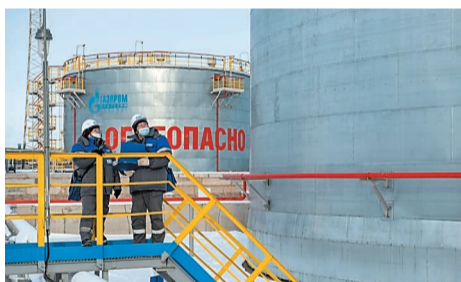
В ТЦЗ завода «Мономер» завершено строительство резервуаров
