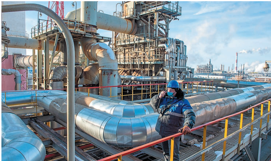
В ходе плановых ремонтов на установке ЭЛОУ АВТ-4 восстановлена работоспособность трубопровода
