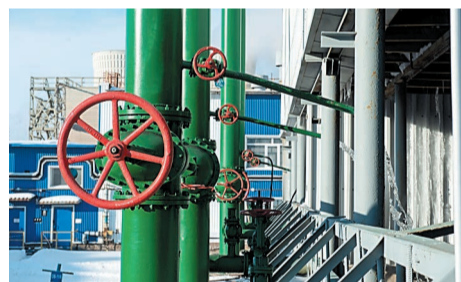
Отремонтирована градирня водооборотного узла установки ЭЛОУ АВТ-4
