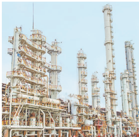
Установки газоразделения и очистки пирогаза цеха № 56
