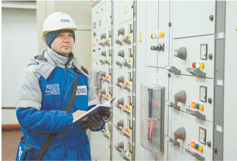
Новая трансформаторная подстанция (КТП)-1 смонтирована в цехе № 50
