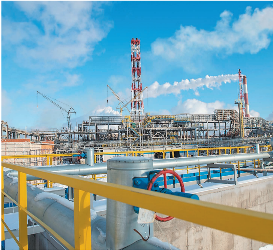
Ведется строительство новой установки производства элементарной серы
