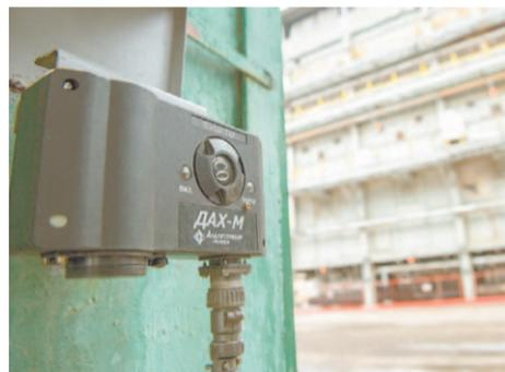
Своевременное обнаружение токсичных веществ в воздухе и их локализация является важной задачей. Эту задачу успешно решают датчики-газоанализаторы, используемые в помещениях и на открытых технологических установках компании
