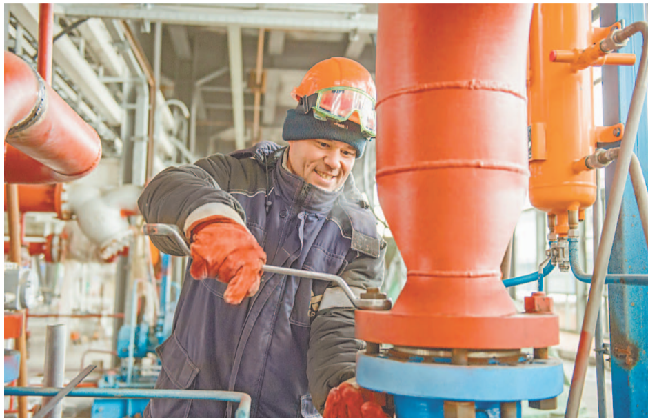
Установка заглушки на строящейся установке изомеризации. Данные работы проводятся согласно инструкции по безопасной организации ремонтных, строительно-монтажных и других работ на объектах Общества, пересмотр которой сделан в 2016 году
