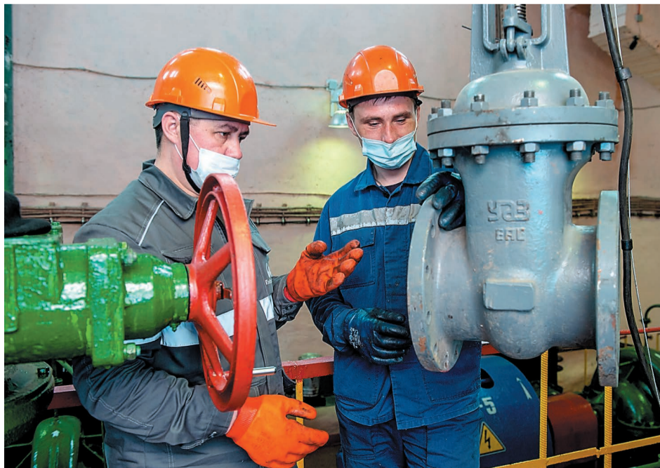
Сотрудники ООО «ПромВодоКанал» готовят насосное оборудование к грядущим паводкам
