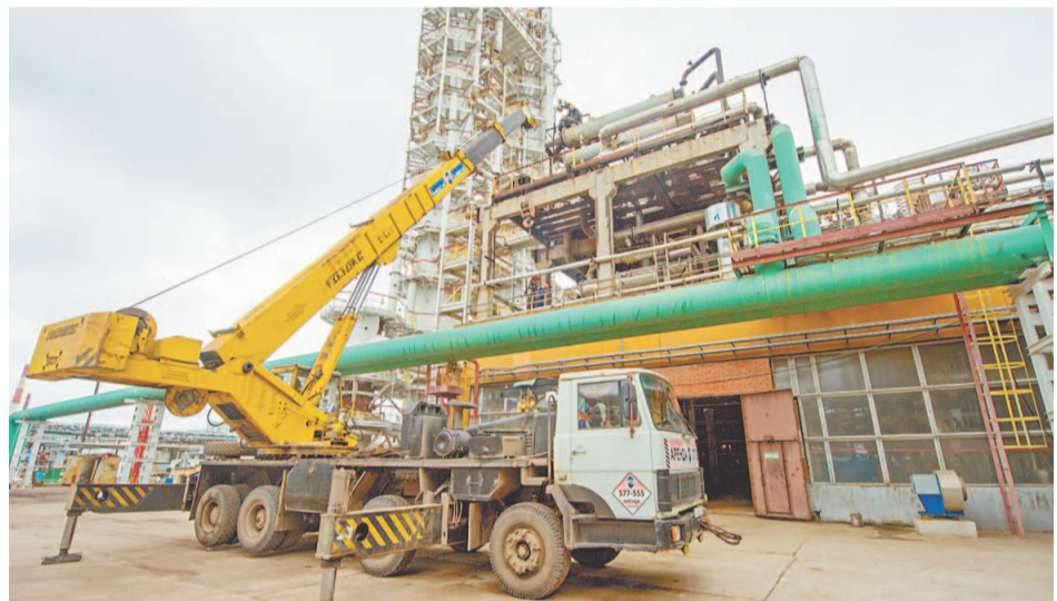
Ремонт на производстве спиртов завода «Мономер»
