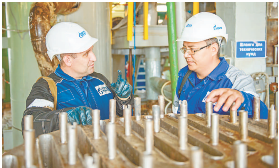
В капитальный ремонт на газохимическом заводе
