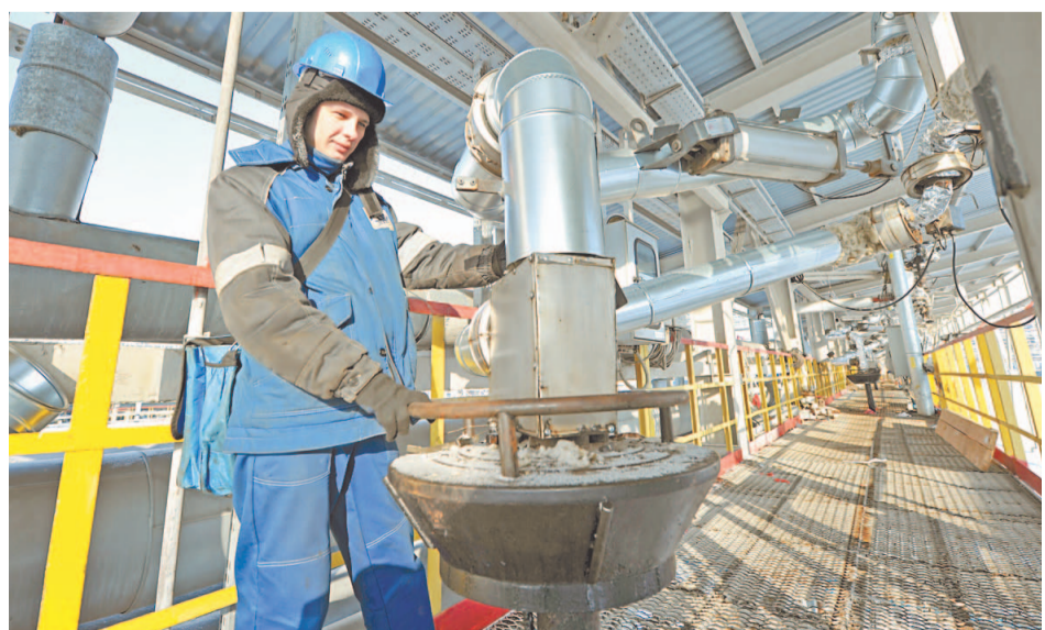
Обновление установки битумов нефтеперерабатывающего завода
