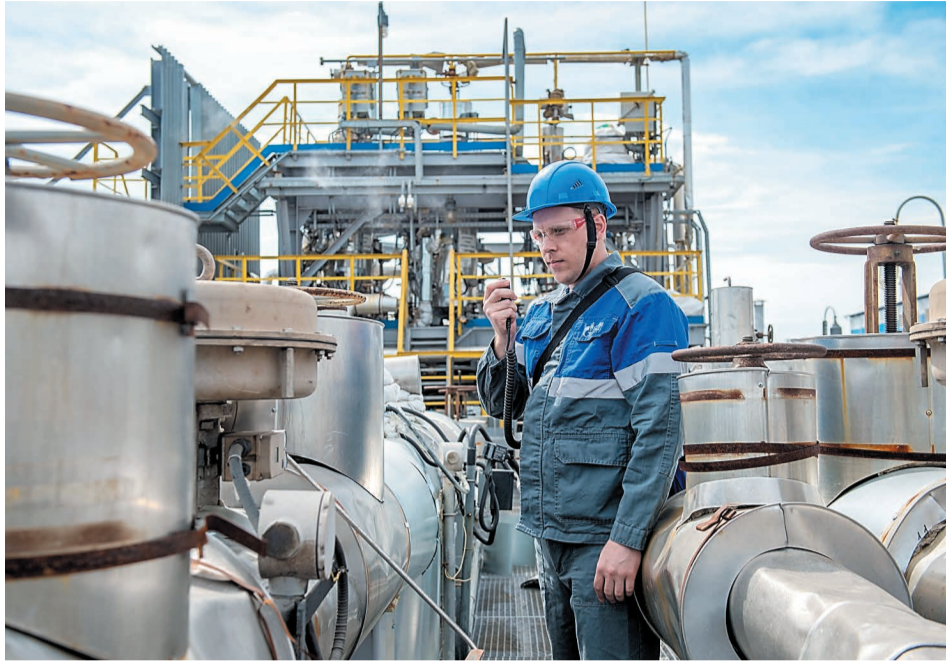
Ремонт для безопасной эксплуатации оборудования и выполнения производственных задач
