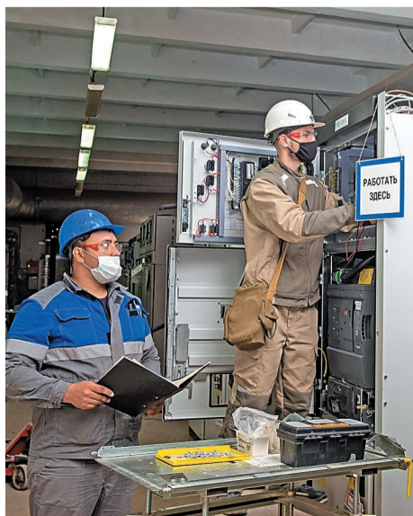
Проверка релейной защиты вновь смонтированного шкафа распределительного устройства 6кВ
