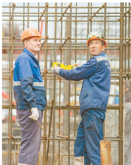
Завершается сборка арматурных каркасов фундаментов компрессорных установок РК-101А/В, РК-102А/В.
