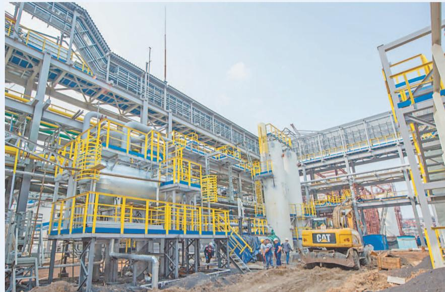
Продолжается строительство установки короткоциклового адсорбции. На снимке: слева расположена факельная емкость, которая в будущем будет служить для разделения газовой и жидкой фазы факельных сбросов. К настоящему моменту завершены работы по электрообогреву и изоляции емкости. Выполнена также покраска смотровой площадки и лестницы.
