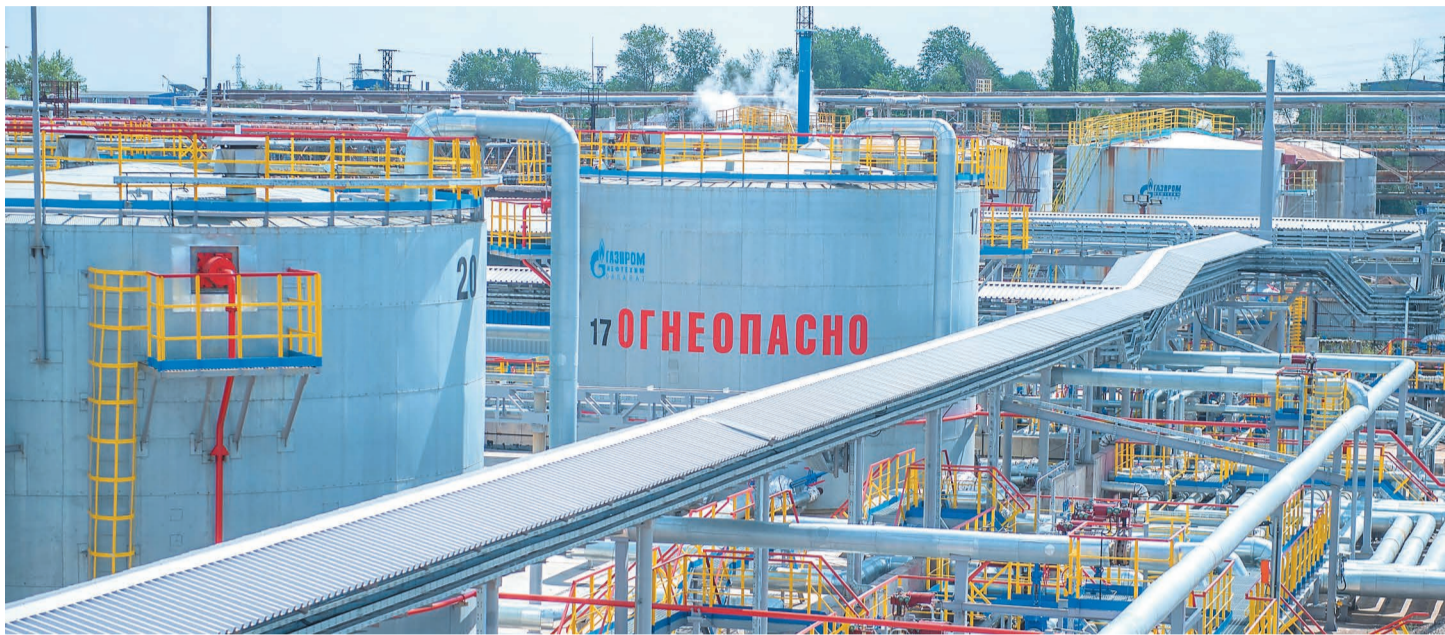
Завершена модернизация северного резервуарного парка цеха № 10
