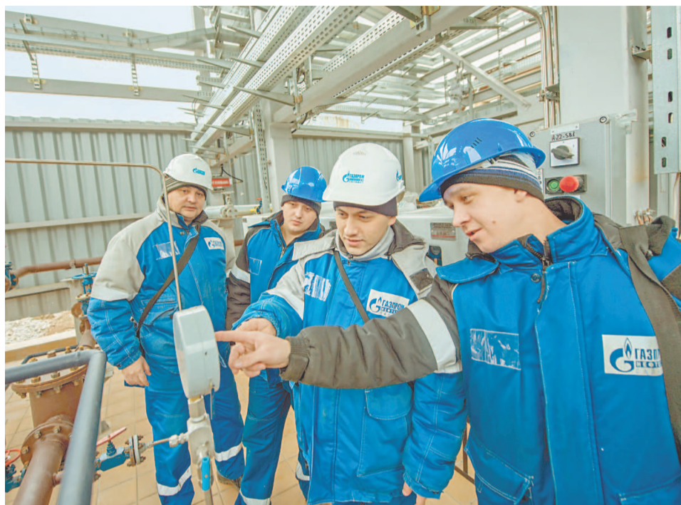
Пусконаладочные работы и обкатка оборудования насосной успешно завершены
