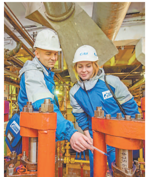
Проверка состояния сальников в насосе высокого давления
