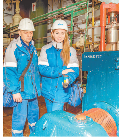
Процесс измерения температуры редуктора с помощью пирометра
