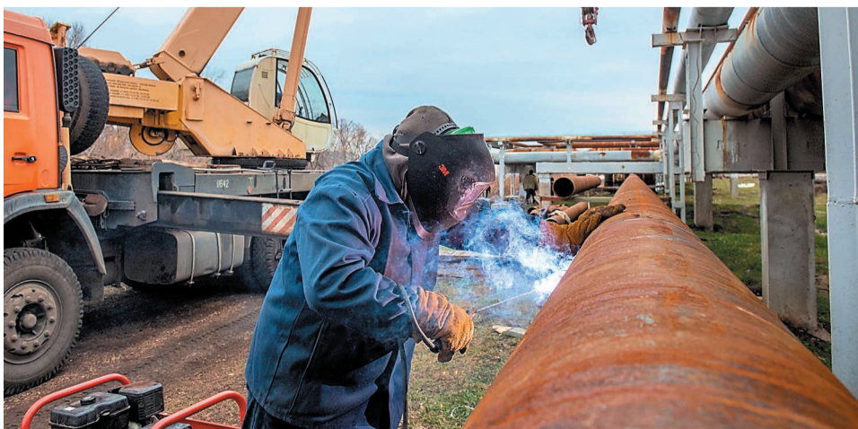
Новый трубопровод предназначен для транспортировки дизельного топлива
