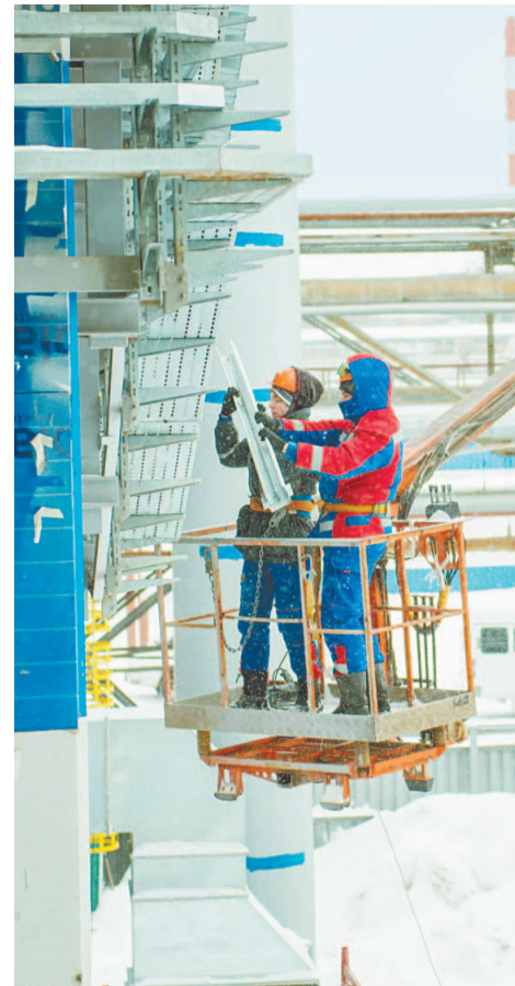
Помимо чистого водорода, установка КЦА также будет вырабатывать остаточный газ, который будет подаваться в топливную сеть компании
