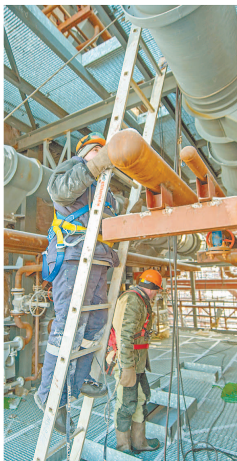
Монтаж трубопроводной обвязки печи
