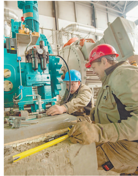
Монтируется уникальное оборудование
