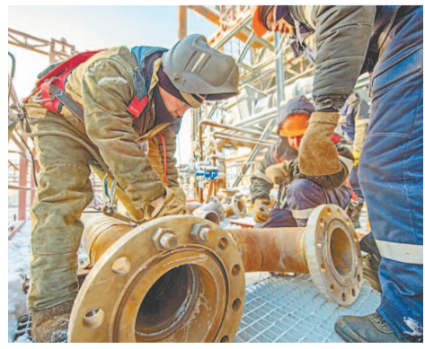
Изготовление трубных заготовок
