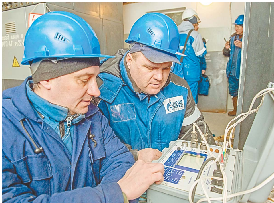
Электроснабжение предприятия зависит от работы ГПП
