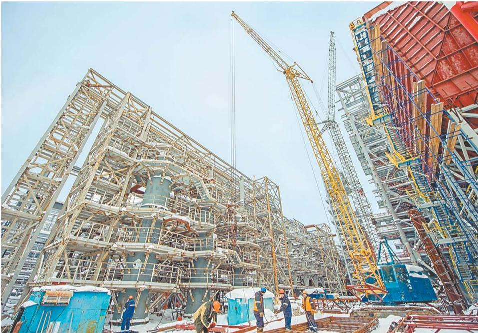
Мощность установки ККФ составит 1095 тыс. тонн по сырью, по бензину – до 54 %, по октану – 93,2.
