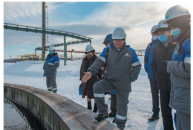
Гостям показали ход реконструкции очистных сооружений
