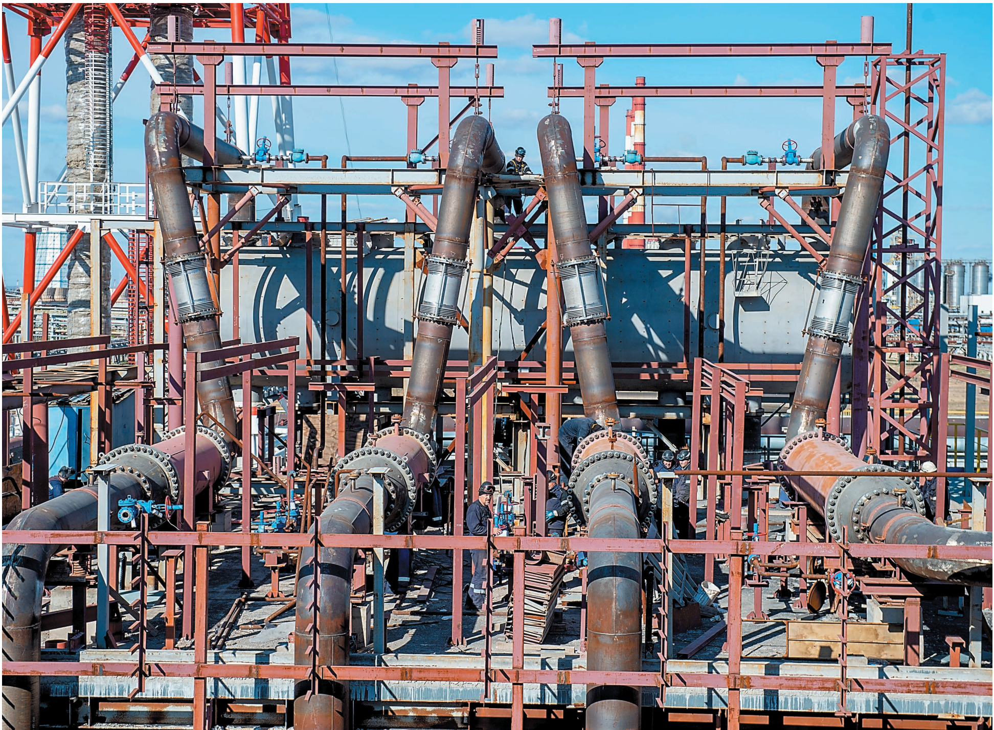
Строительство установки по производству серы
