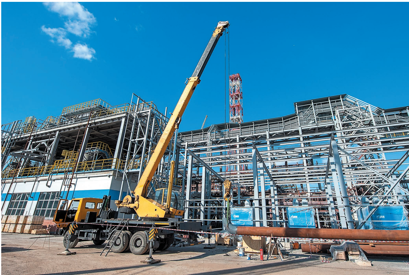
Ведется строительство установок производства серы
