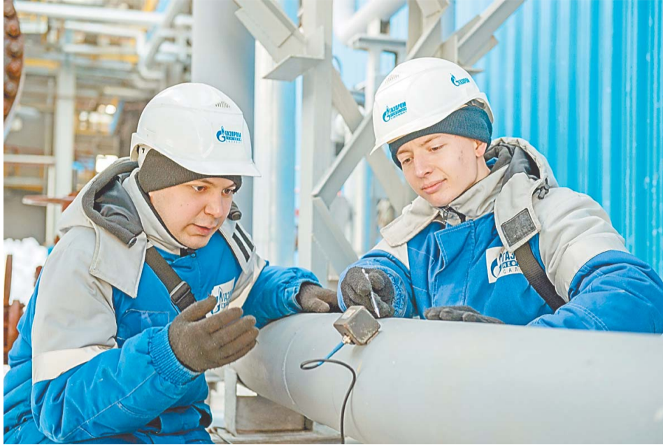
Установка и калибровка датчиков на контролируемом трубопроводе перед началом пневмоиспытания
