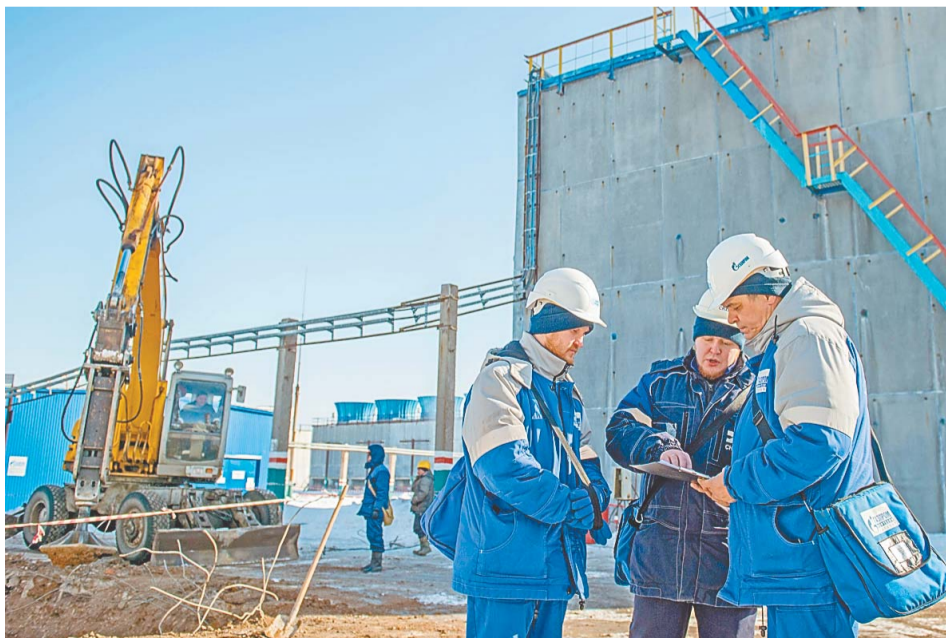
Строительные работы на водооборотном узле № 639
