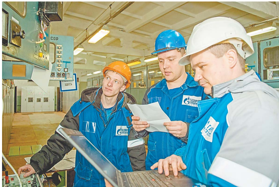
Модернизация на РТП-16 прошла в капитальный ремонт
