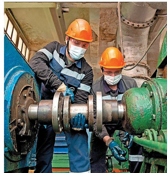
Плановый ремонт – залог стабильной работы оборудования
