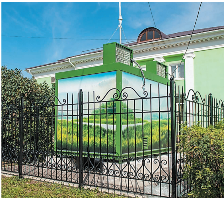
Станция в районе краеведческого музея в г. Салавате
