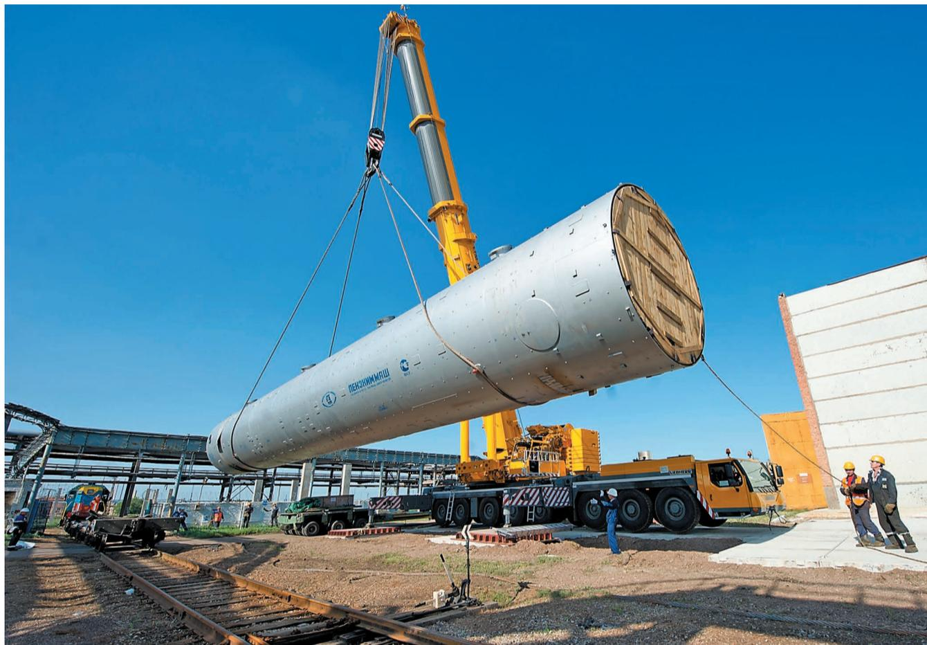
Колонна для установки риформина Л-35/11-1000 отечественного производства доставлена на промышленную площадку, впоследствии установлена на производстве. Фото из архива
