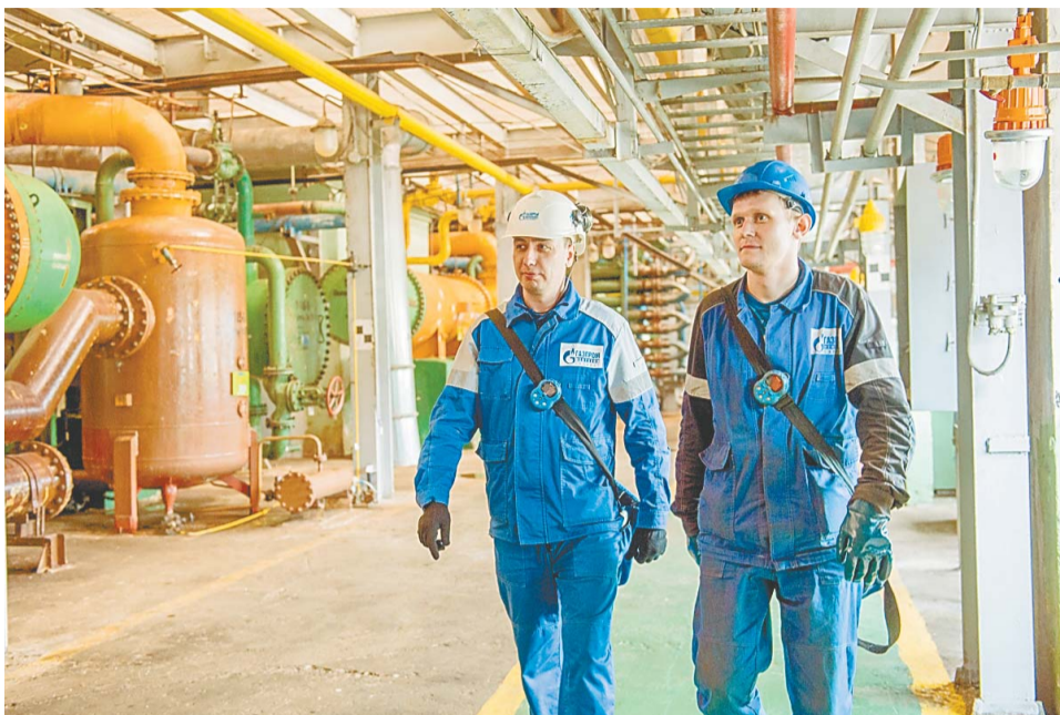
Обход технологического оборудования после выхода из капитального ремонта в цехе № 51
