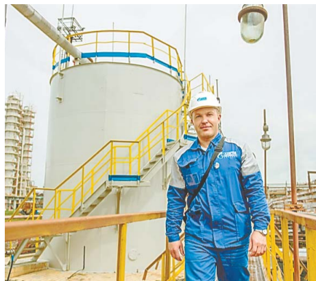
Резервуар Р-17 работники цеха № 52 самостоятельно очистили от загрязнений
