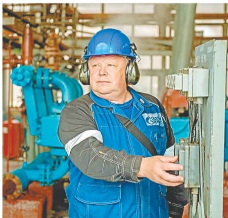
В насосной ВД цеха № 52 были заменены фундаменты насосов. На фото — старший машинист установки № 4 Иван Куликов
