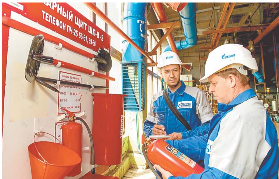
В Обществе проверена укомплектованность объектов первичными средствами пожаротушения
