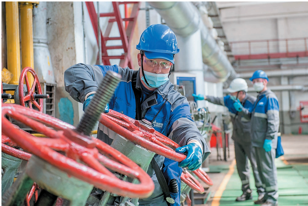
Смонтирована схема подачи сдува ВСГ с установки ГО-2 на установку КЦА
