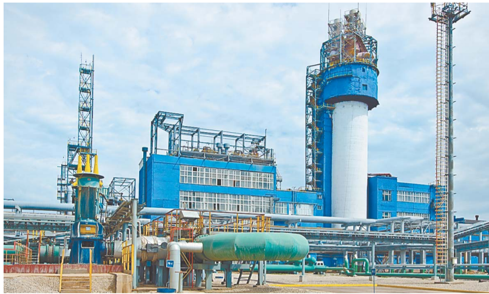
Волна капитальных ремонтов дошла и до газохимического завода
