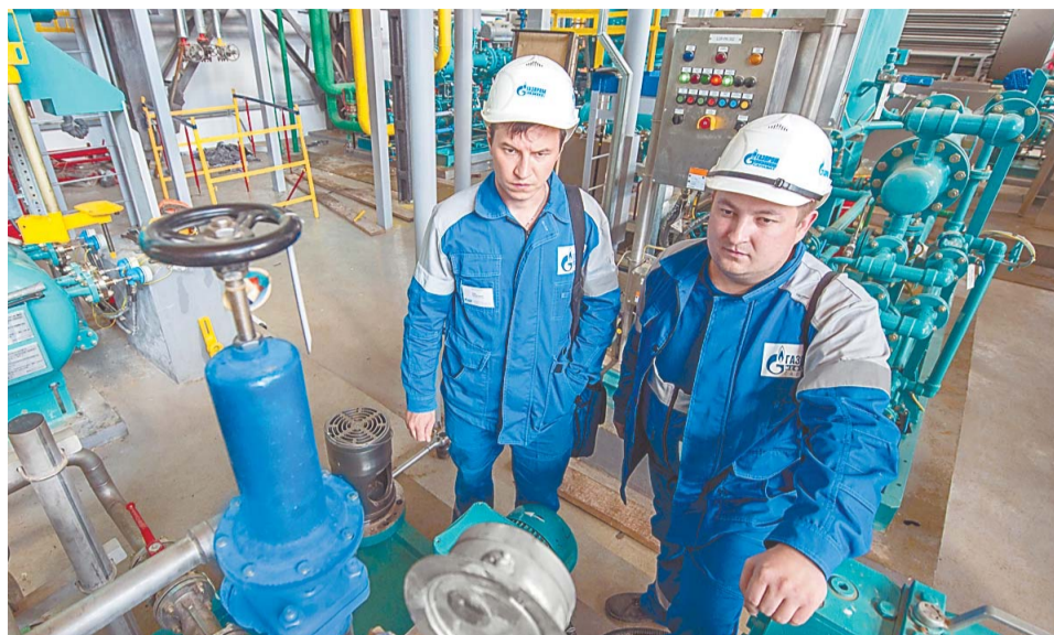
На установке КЦА проводится отладка каналов связи, проверка всех систем питания и обкатка оборудования вхолостую
