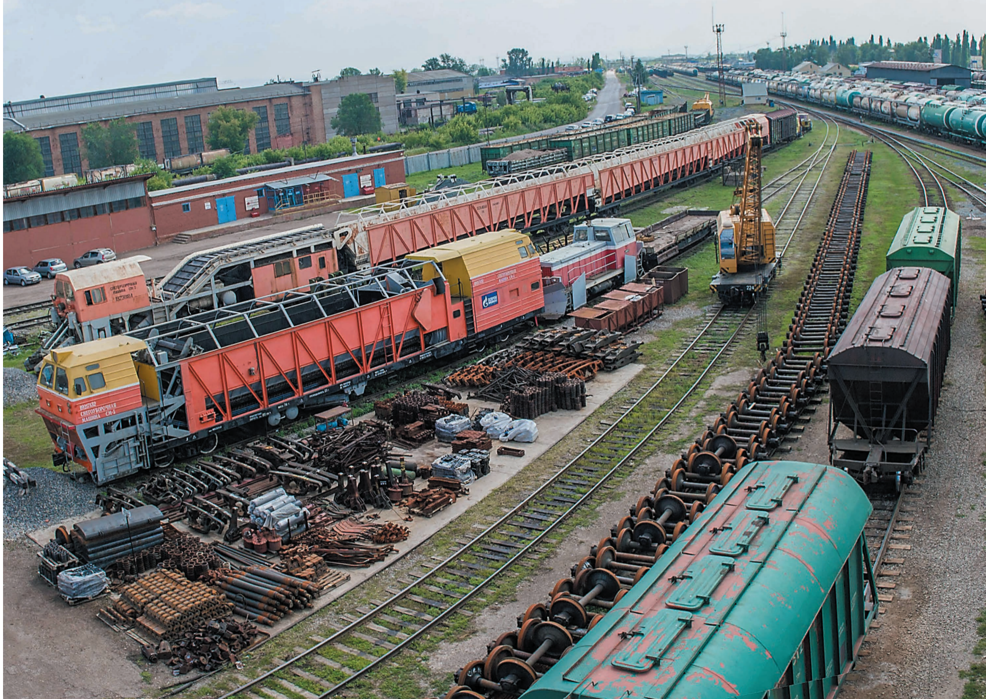
Железнодорожные пути вагонного депо ООО «ППЖТ»
