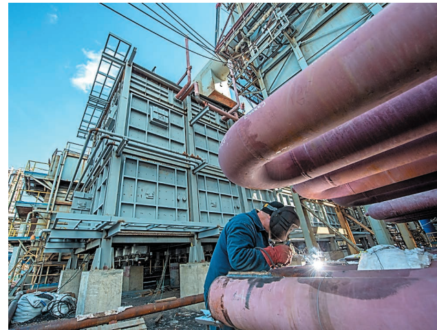
Монтаж новой печи на установке ГО-4
