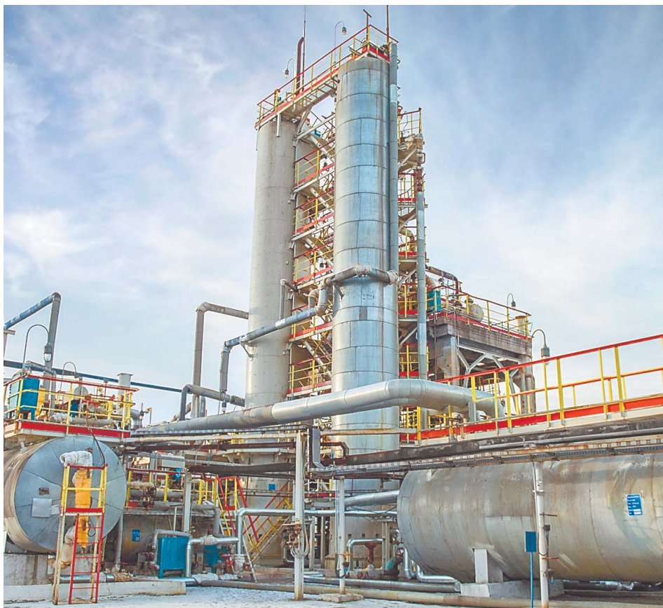
На установке ОГиКТ происходит очистка топливных газов от сернистых соединений перед их подачей на установки для вторичного использования
