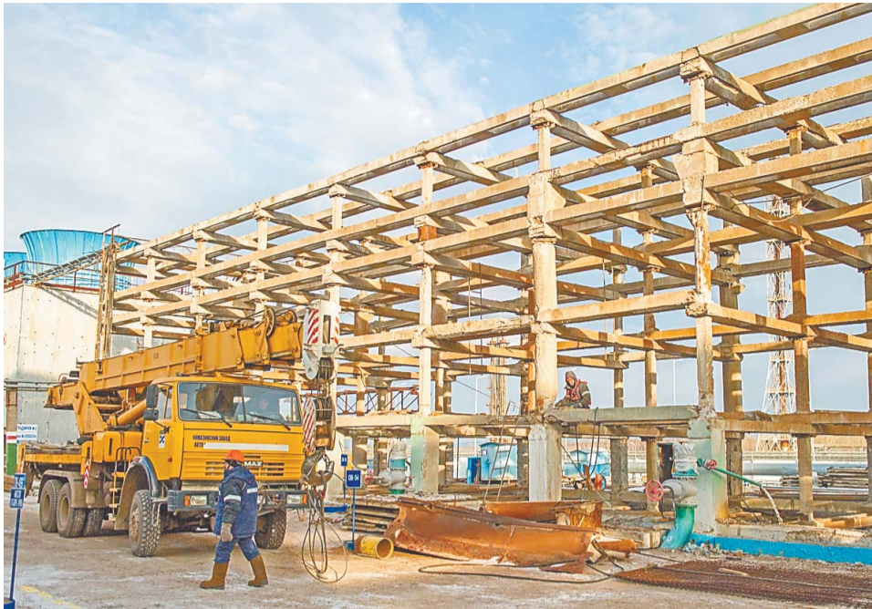
На градирне № 2 начался процесс обновления: разобрана обшивка градирни и все внутренние изношенные детали
